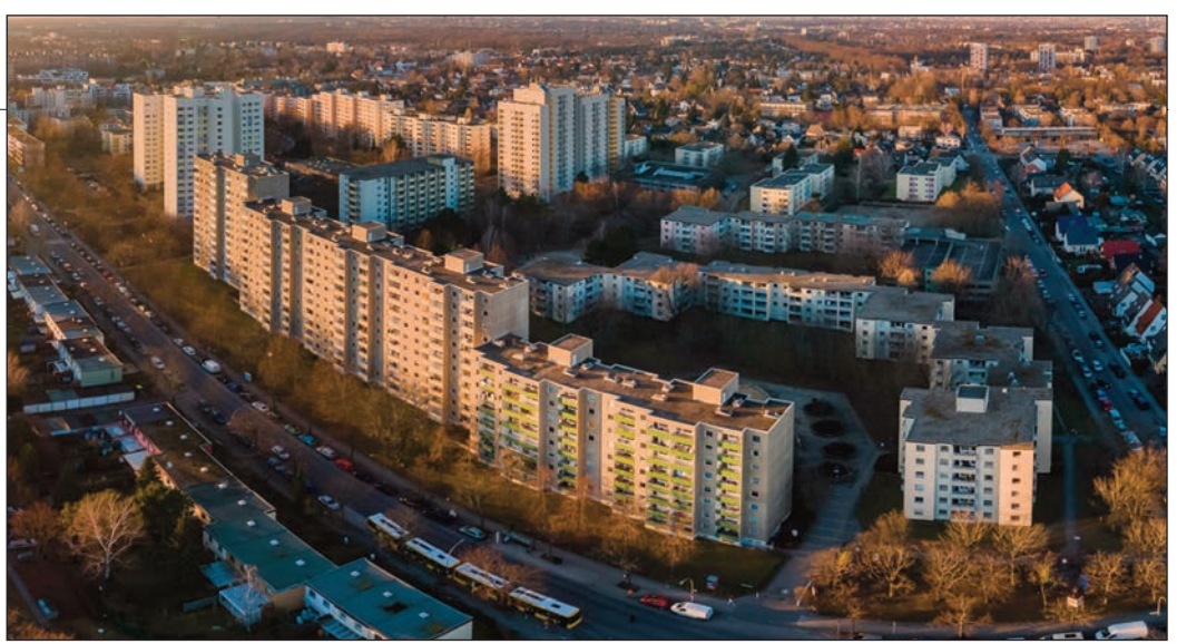
Vorn die Ringslebenstraße, dahinter die Gewobag-Siedlung aus den 60-er Jahren. Die höchsten Häuser haben 18 Stockwerke.
